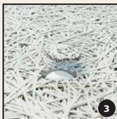
ilpas den afskårne træbeton til hullets geometri, og placer den i hullet
