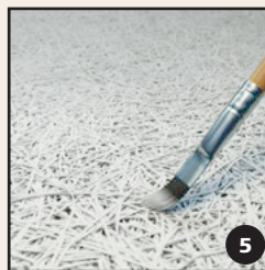
Brug reparationsmaling i samme farve som pladen
