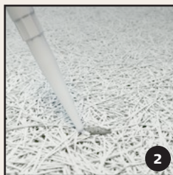
Påfør fugemasse
